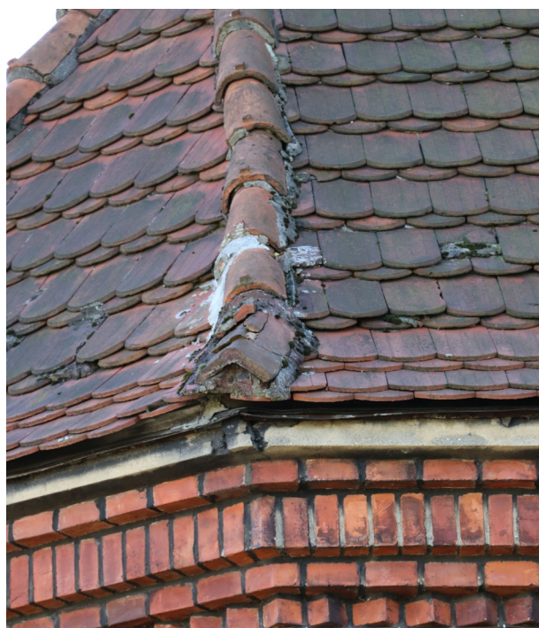
fot. 12: Kaplica cmentarna - reperacja gąsiora za pomocą zaprawy cementowej.
