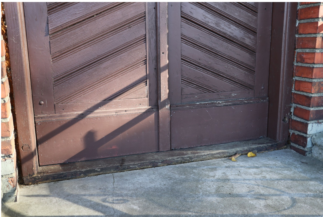
fot. 6: Kaplica cmentarna - widoczne uszkodzenia farby wierzchniej progu i skrzydeł drzwiowych.
