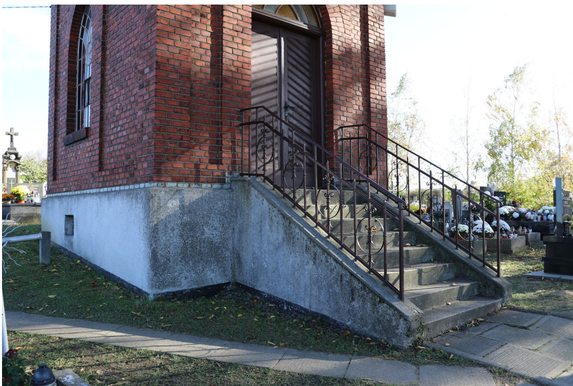
fot. 3: Kaplica cmentarna - widoczna podmurówka pokryta nalotem atmosferycznym i biologicznym.
