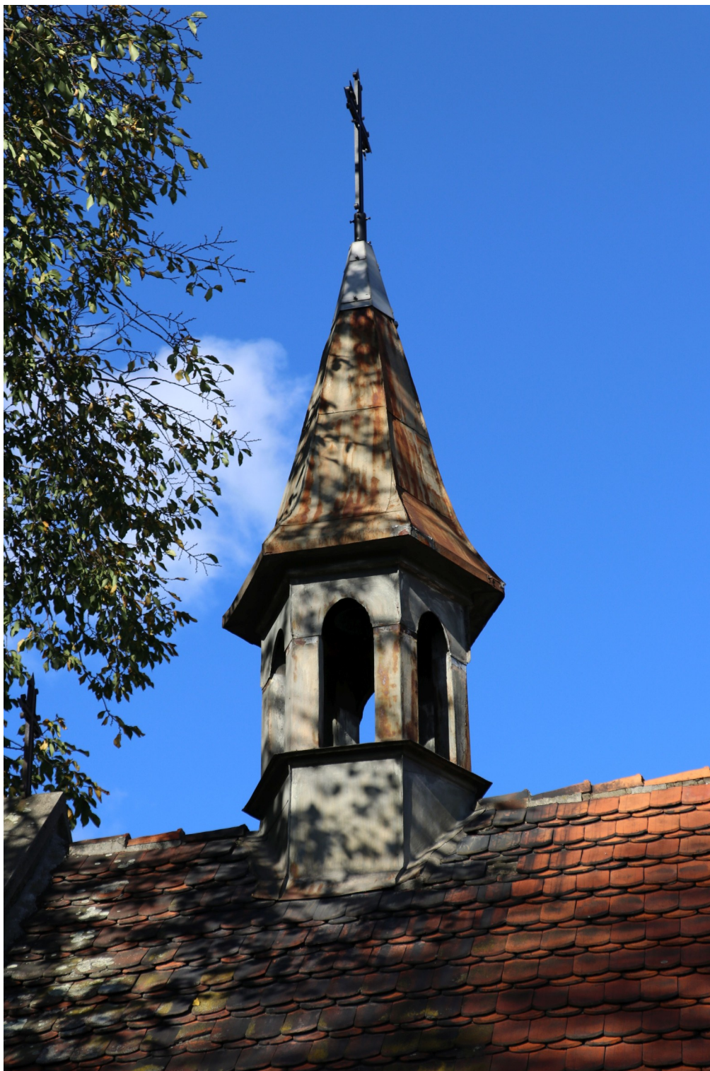
fot. 18: Kaplica cmentarna - widoczna korozja na sygnaturce.
