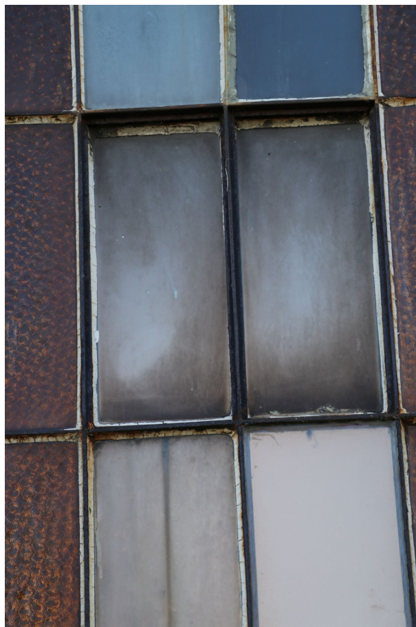
fot. 24: Kaplica cmentarna - widoczne zabrudzenia powierzchniowe oraz korozja konstrukcji metalowej.
