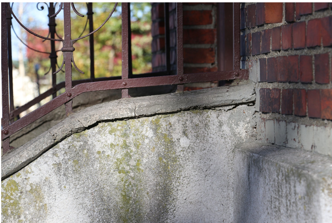
fol. 22: Kaplica cmentarna - widoczne uszkodzenie czapki policzka schodów.
