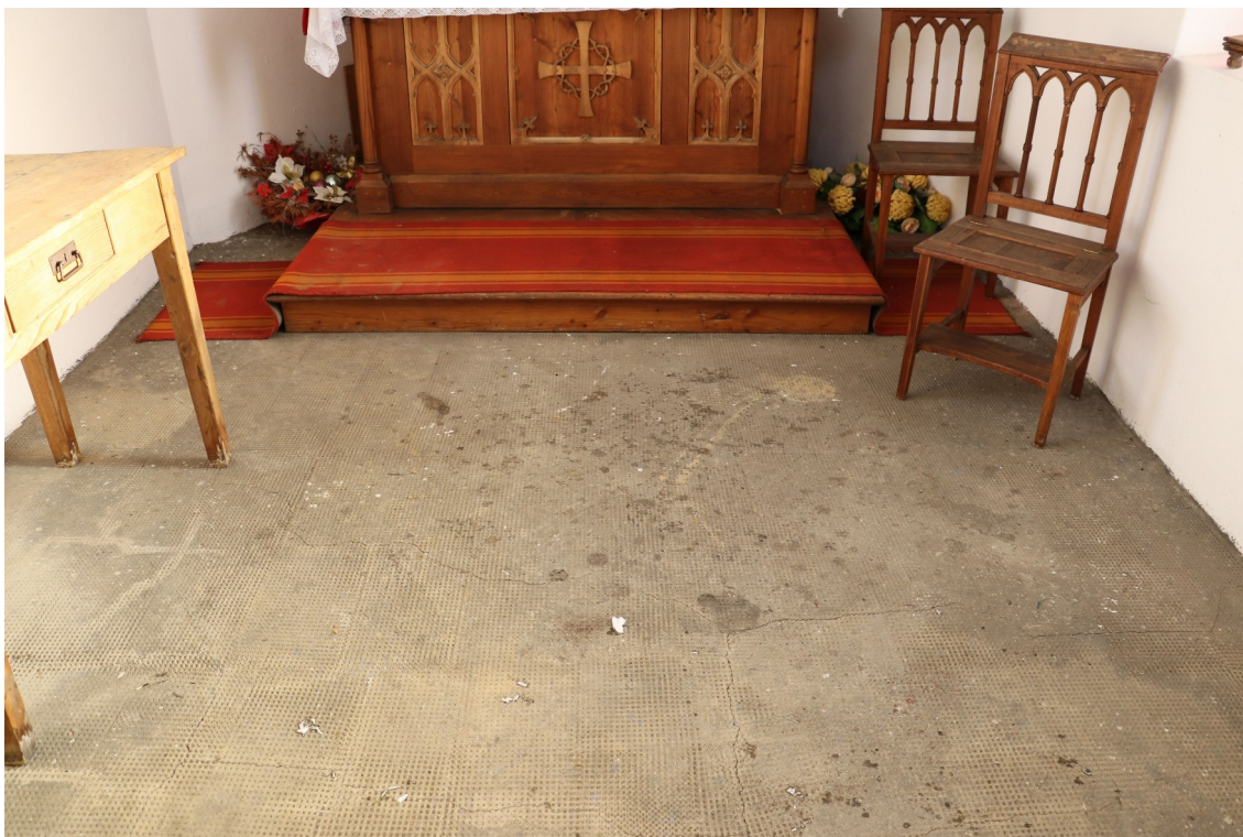
fot. 33: Kaplica cmentarna - widoczna istniejąca posadzka betonowa z uszkodzeniami.
