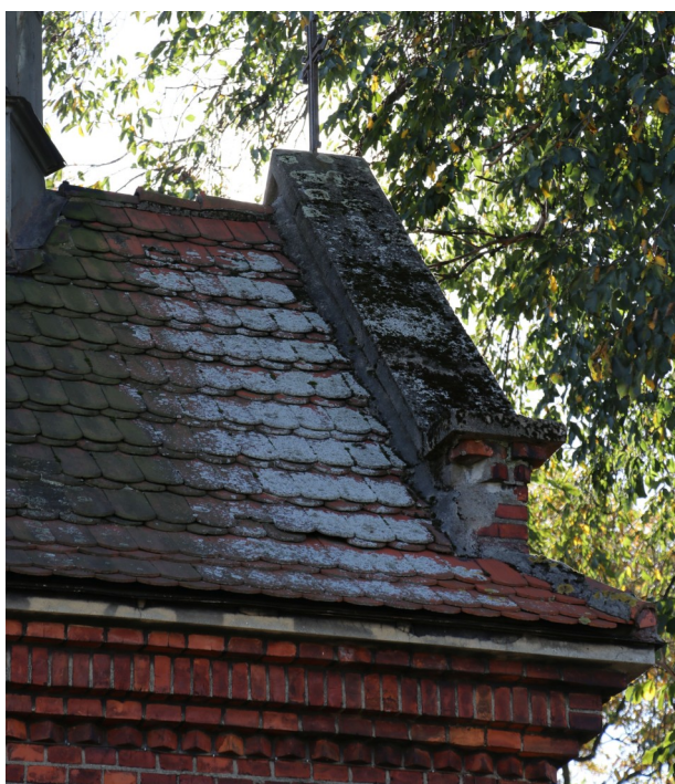
fot. 11: Kaplica cmentarna - nalot biologiczny na pokryciu dachowym.
