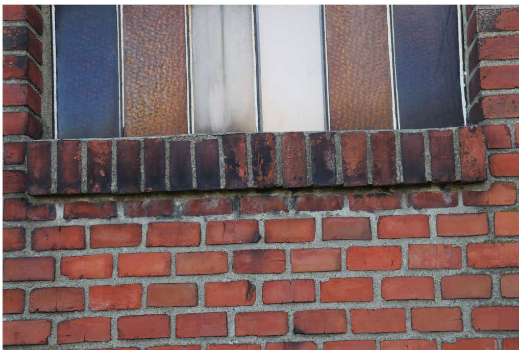
fot. 28: Kaplica cmentarna - widoczne zabrudzenia parapetu.
