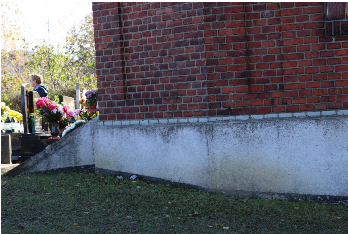
fot. 13: Kaplica cmentarna - podmurówka pokryta nalotem atmosferycznym i biologicznym.
