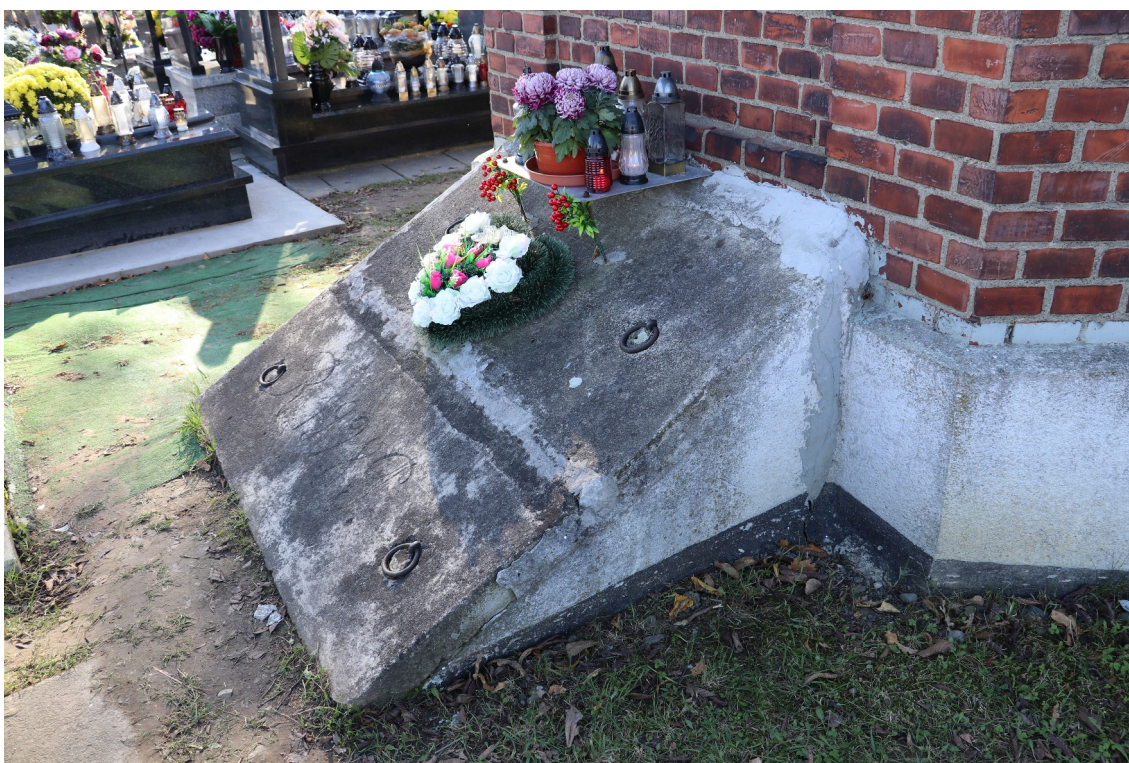
fot. 14: Kaplica cmentarna - widoczne płyty przykrywające wejście do krypty uzupełnione wtórnie zaprawą cementową.
