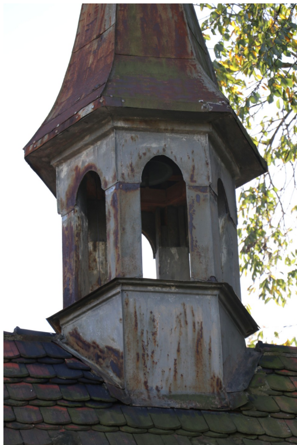
fot. 10: Kaplica cmentarna - skorodowana podstawa sygnaturki.
