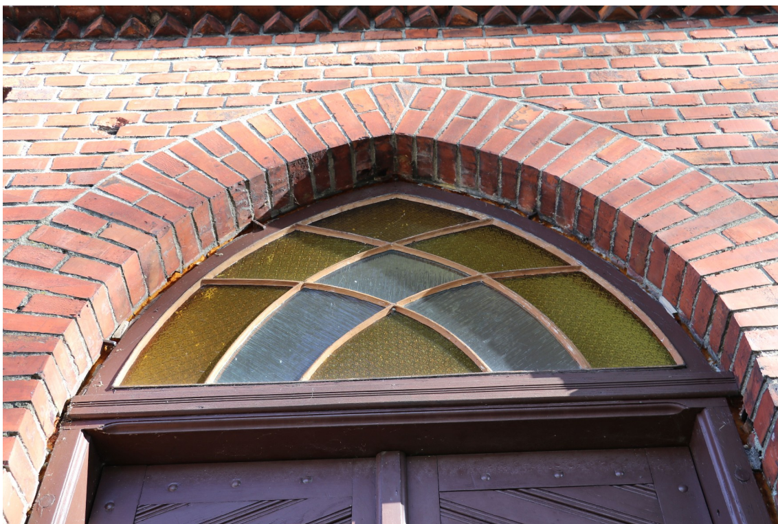
fot. 7: Kaplica cmentarna - ostrołukowe nadświetle drzwi wejściowych.
