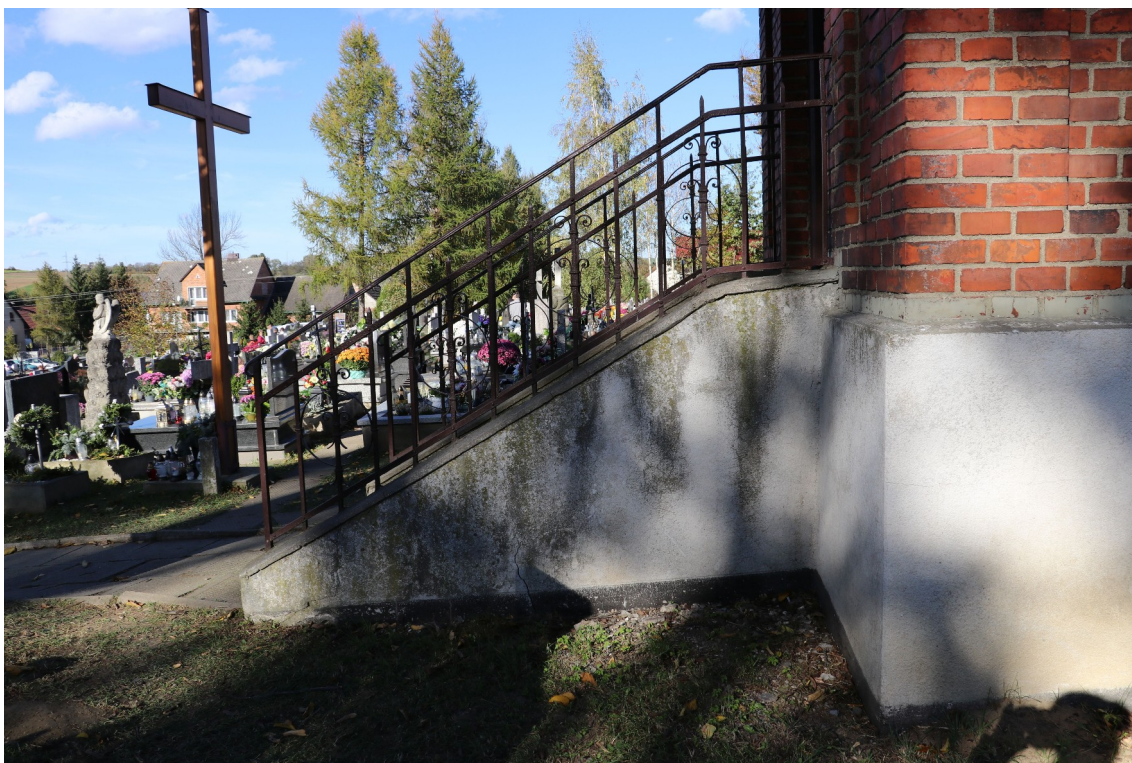
fol. 21: Kaplica cmentarna - widoczny nalot atmosferyczny i biologiczny na podmurówce.
