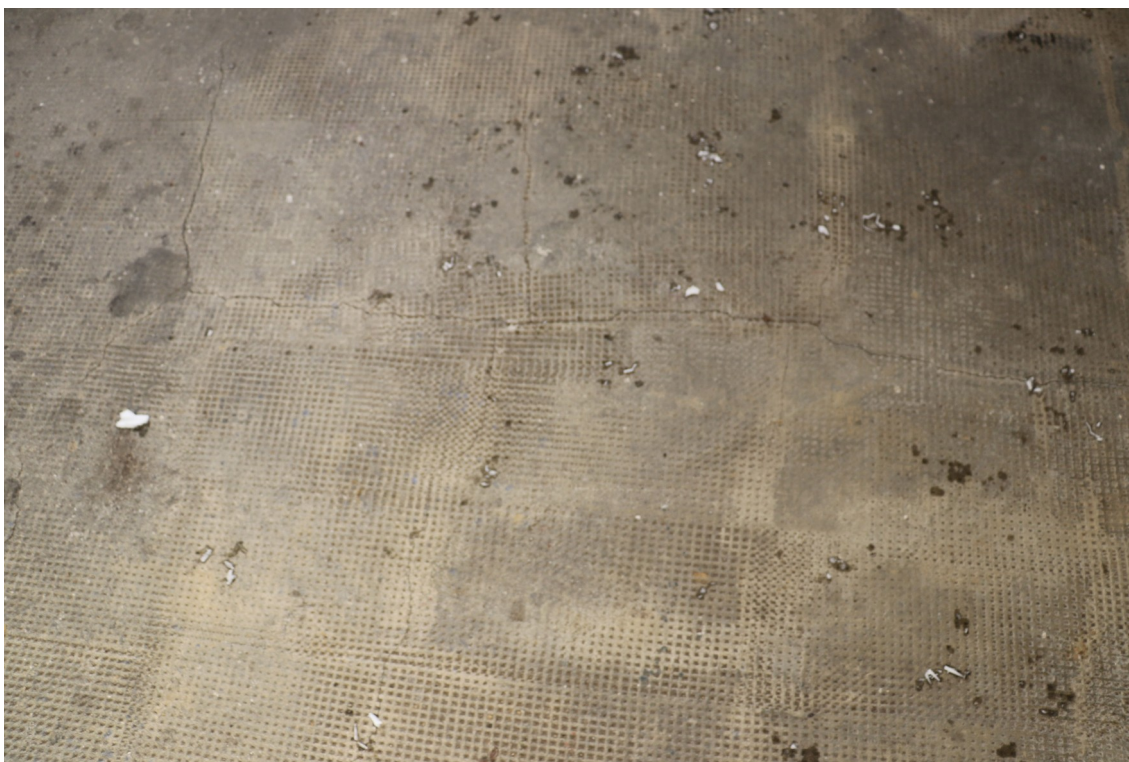
fot. 34: Kaplica cmentarna - widoczne pęknięcia posadzki betonowej.
