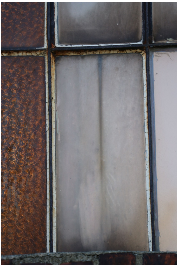
fot. 26: Kaplica cmentarna - widoczna korozja konstrukcji metalowej oraz uszkodzenia kitów.
