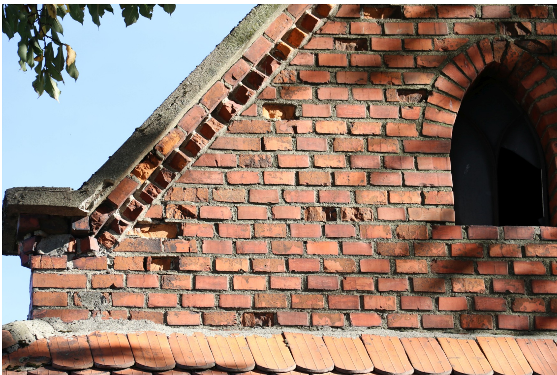
fot. 2: Kaplica cmentarna - szczyt elewacji frontowej. Widoczne uszkodzenia wątku ceglanego.
