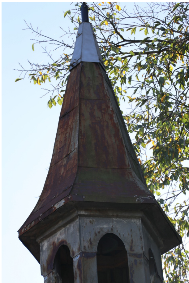
fot. 9: Kaplica cmentarna - skorodowane pokrycie helmu sygnaturki.
